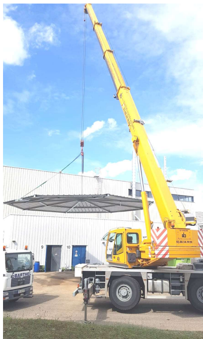
Remplacement d'une couverture de réservoir d'eau Site ZSCHIMMER&SCHWARZ, Wissembourg
