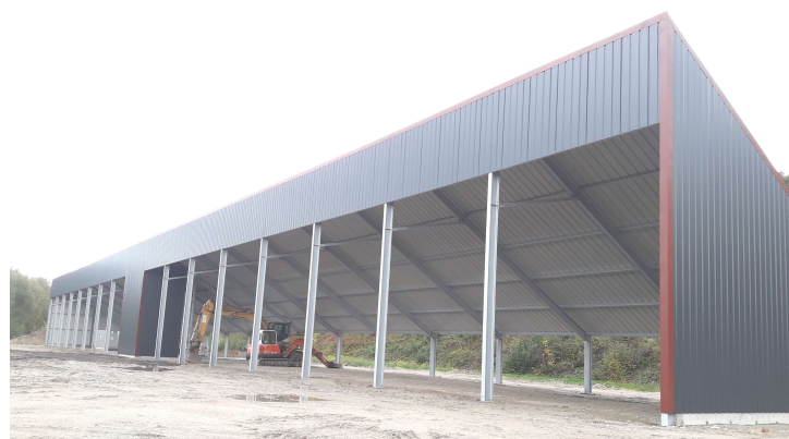
Auvent pour équipement solaire thermique Site TIMMEL FRERES, Beinheim
