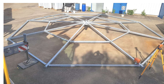
Remplacement d'une couverture de réservoir d'eau Site ZSCHIMMER&SCHWARZ, Wissembourg
